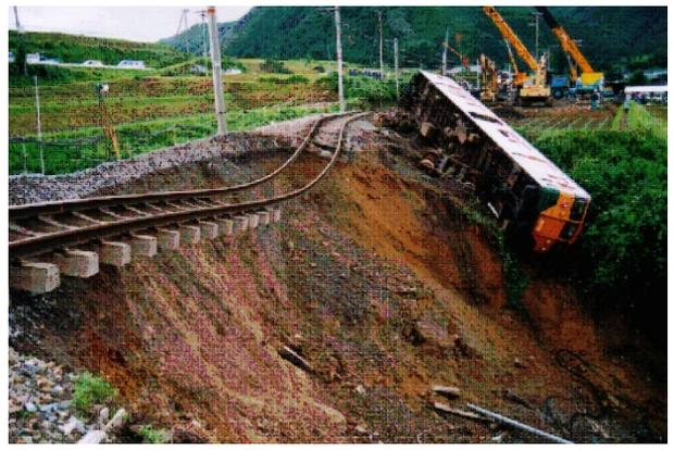
平成 9 年 6 月 和知町内の山陰本線で軌道敷が崩壊し列車脱線事故が発生
